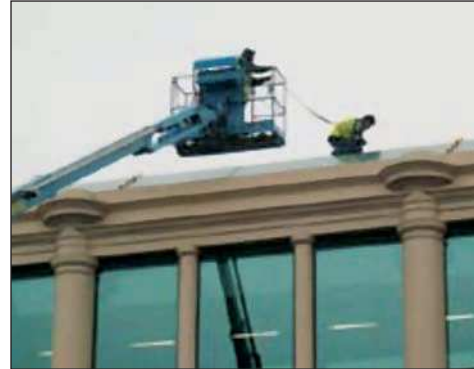
Figura 9 - Lavoro su una copertura con DPI anticaduta del lavoratore agganciato al cestello
