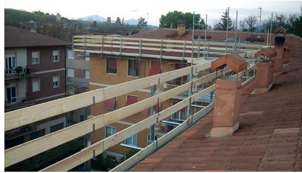
In commercio sono presenti svariate tipologie di parapetti provvisori al fine di permettere un'ampia adattabilità alle differenti condizioni di impiego:
