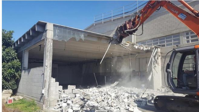
*Esempio di utilizzo escavatore con pinza per demolizione fabbricato*
