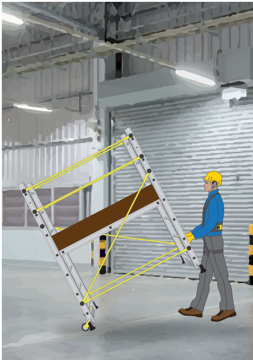
Figura 5 - Spostamento di un piccolo trabattello
