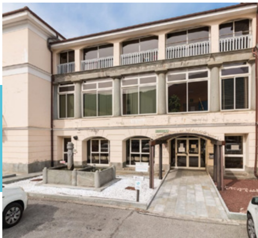
FIG. 8: Torre Pellice – ingresso ospedale valdese
