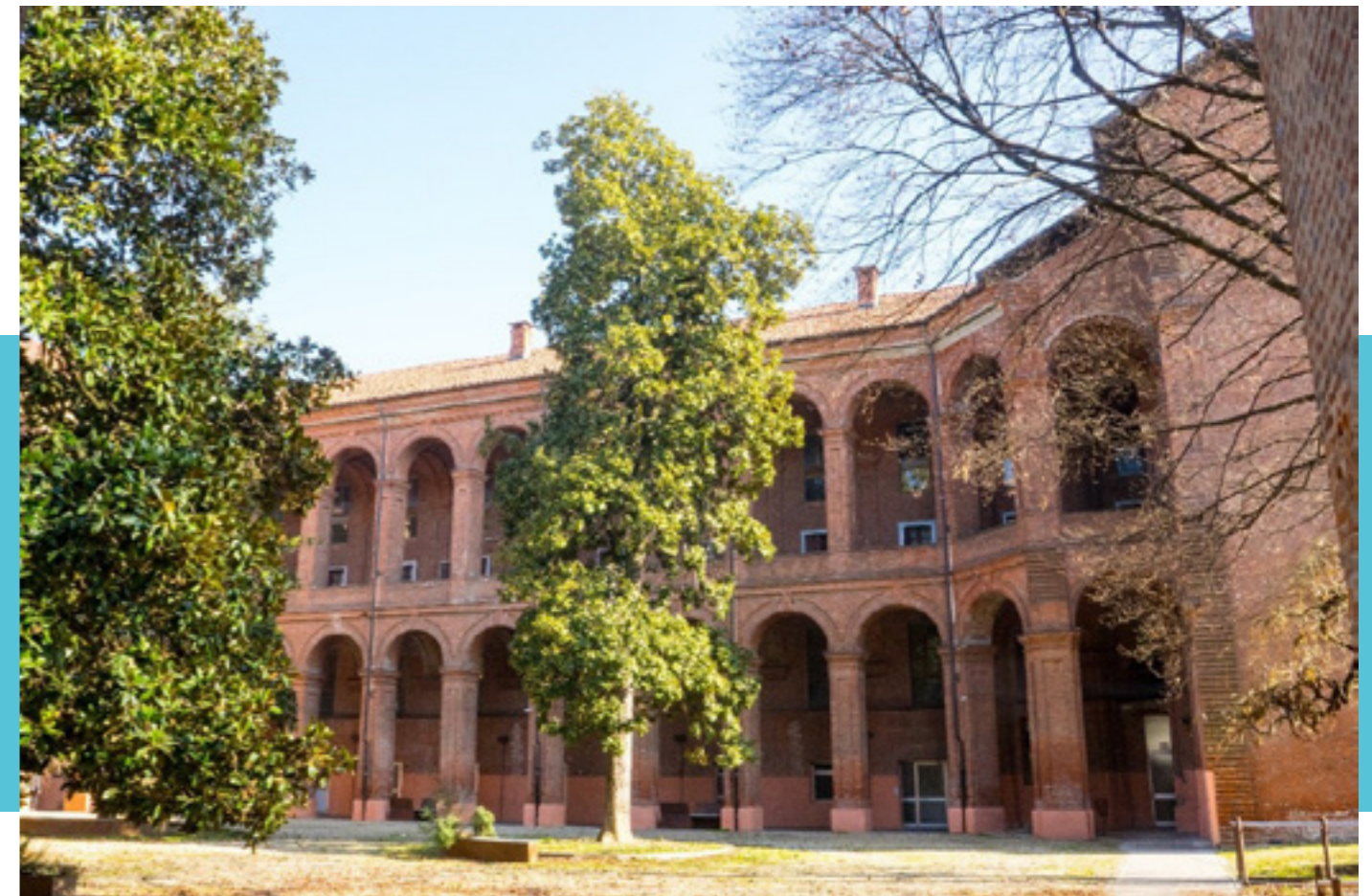
FIG. 8: Carmagnola – veduta cortile interno
