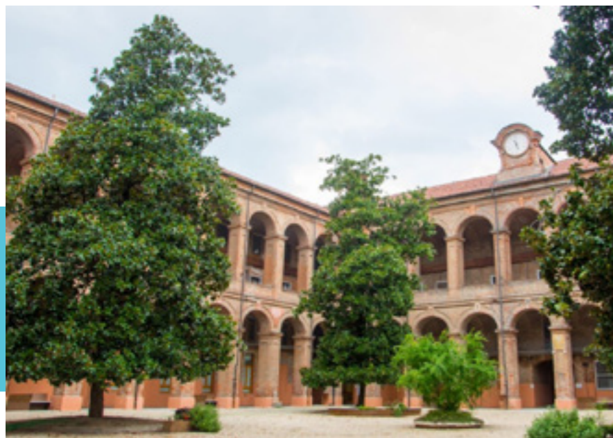
FIG. 7: Carmagnola – veduta cortile interno
