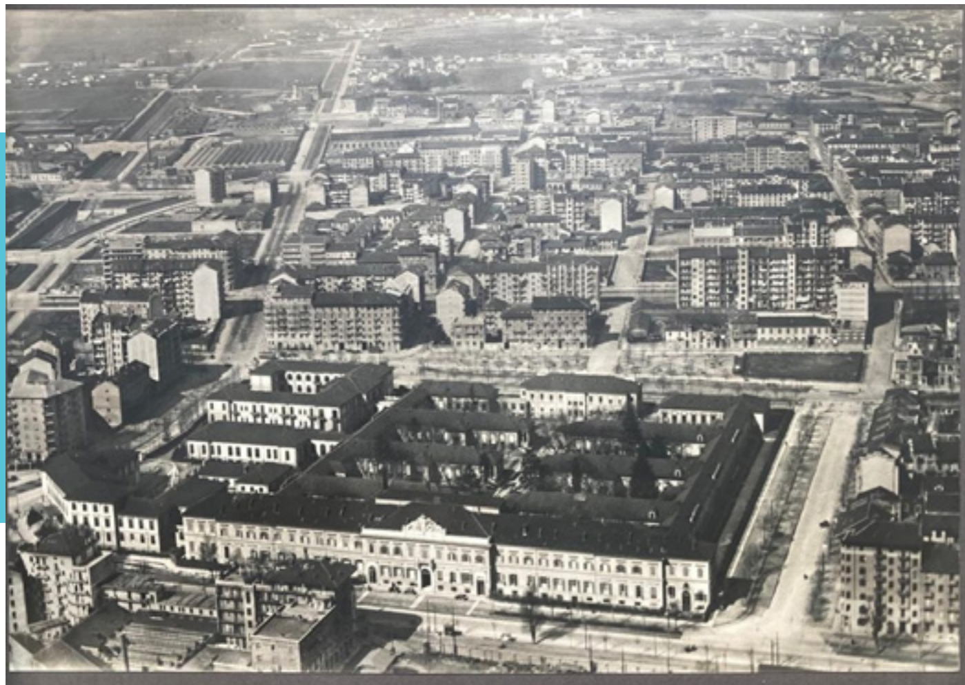
FIG. 7: Ospedale Mauriziano Umberto I – veduta aerea seconda metà '900
