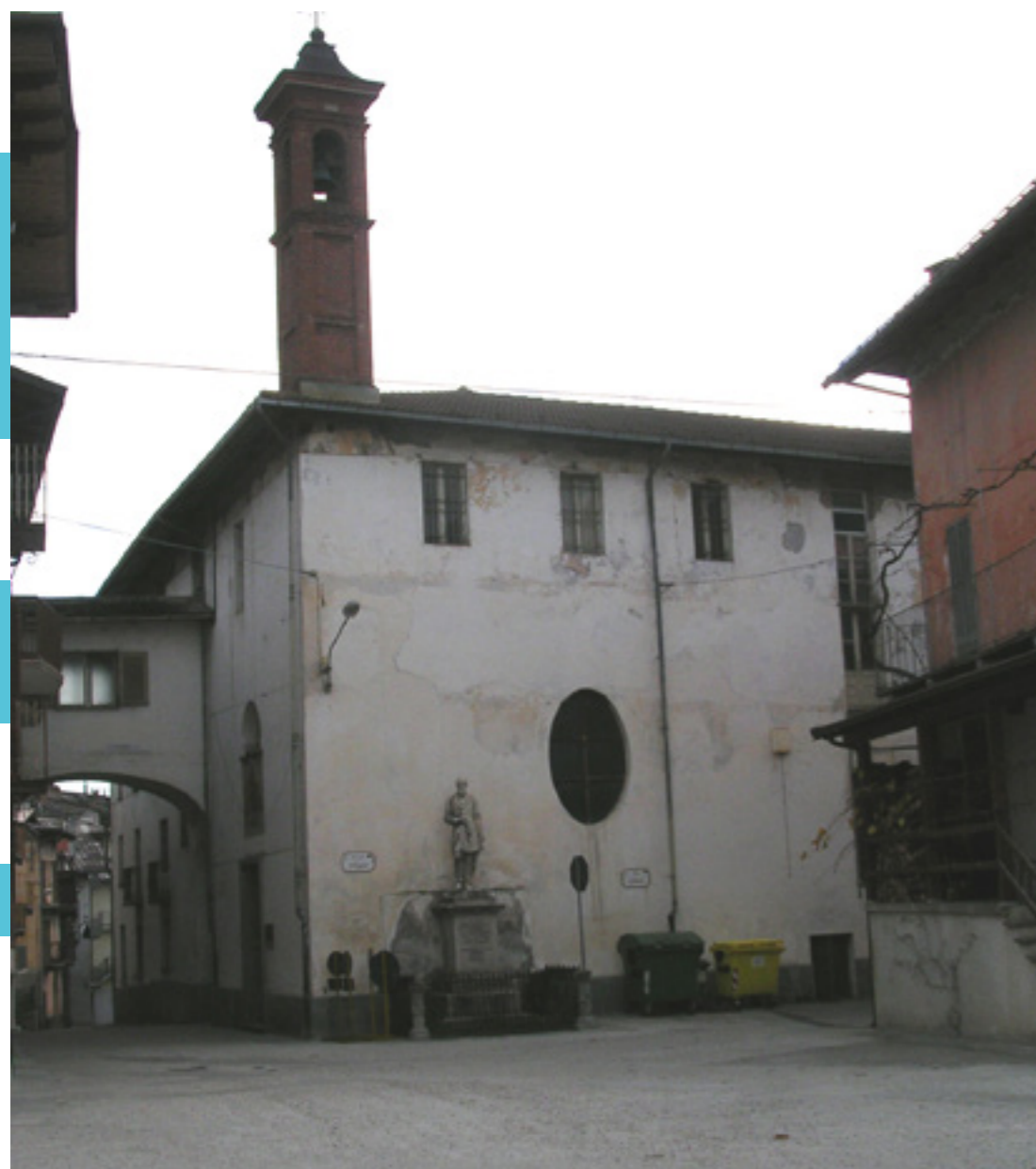
FIG. 9: Ex Ospedale Civile di Demonte
