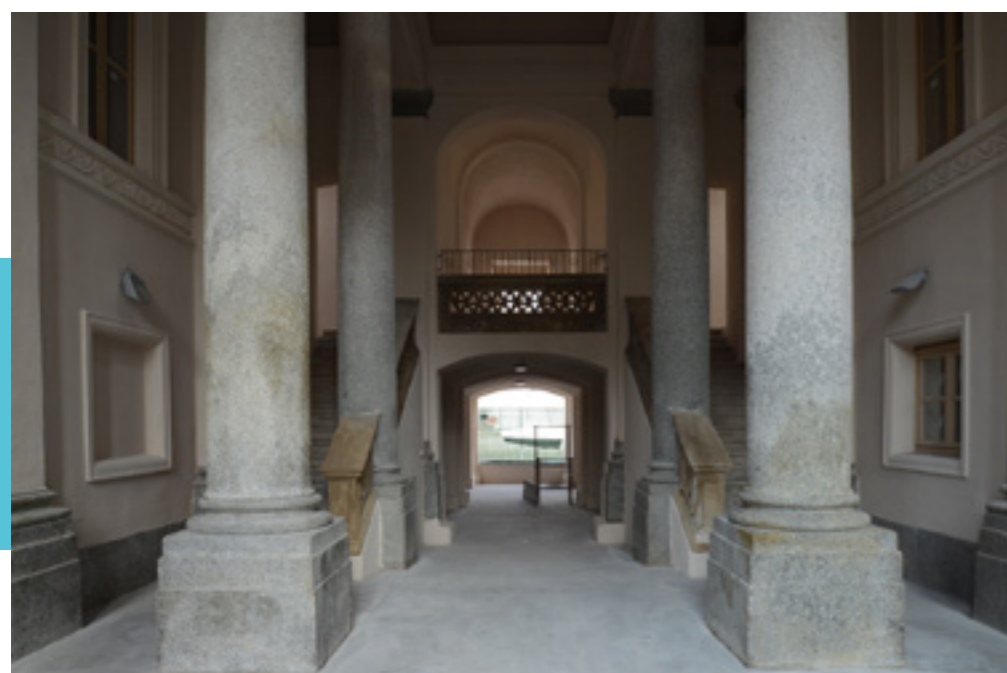
FIG. 8: Interno del Padiglione ex 18 dell'ex Ospedale di Sant'Andrea dopo gli interventi di restauro (2015) (@elenafranco)
