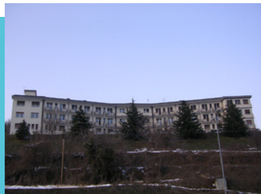
FIG. 10: Ex Ospedale Civile di Demonte
