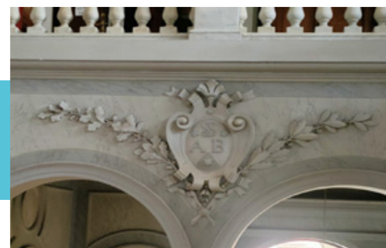
FIG. 9: Stemma dell'ospedale (particolare scalone interno)
