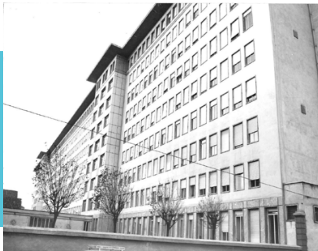
FIG. 5: Padiglione monoblocco (1959-1960 archivio fotografico Biblioteca Biomedica)
