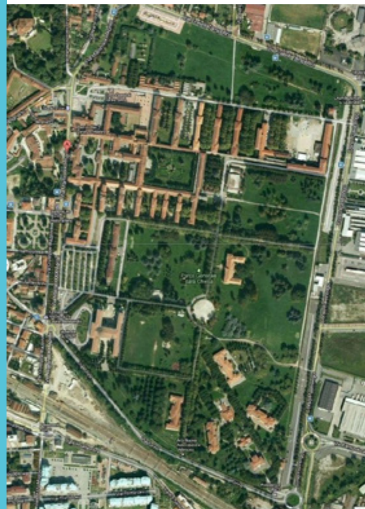
FIG. 5: Certosa di Collegno – veduta aerea
