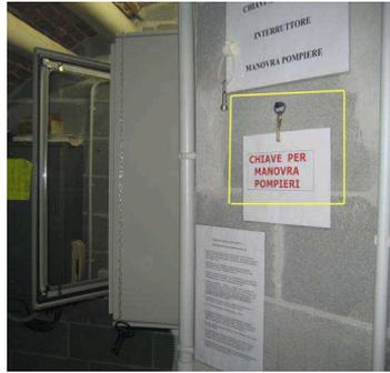
4) recarsi al piano principale dell'impianto (in questo caso al piano terreno) e rompere il vetro. Azionare l'interruttore per iniziare la manovra pompieri (posizione 1), contemporaneamente si accenderanno automaticamente anche le lampade di illuminazione del vano corsa.
