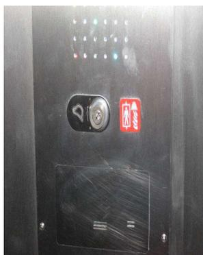
6) Il vigile del fuoco quindi preme un piano di destinazione, l'impianto raggiunge il piano ma non apre la porta che si aprirà solo premendo il pulsante di apertura porte (per permettere al vigile del fuoco di decidere se è sufficientemente sicuro lo sbarco dalla cabina oppure no) successivamente il vigile del fuoco torna al piano principale ed il ciclo può ricominciare.
